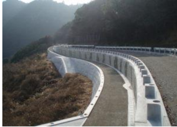
県道鴨川停車場五色台線道路 改築工事(平成25年)
