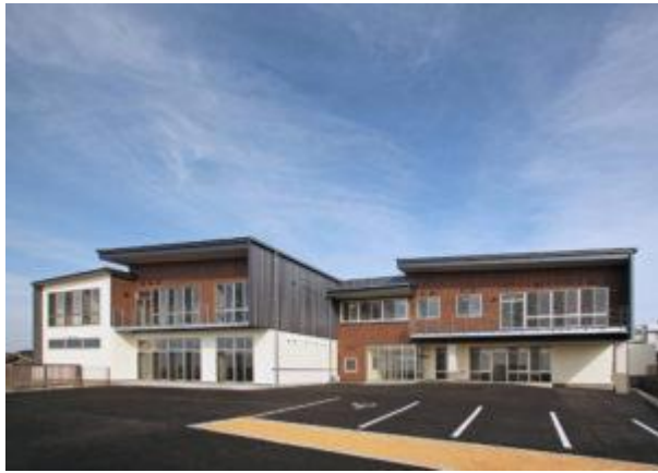
広域型特別養護老人ホーム ネムの木施設建設工事
