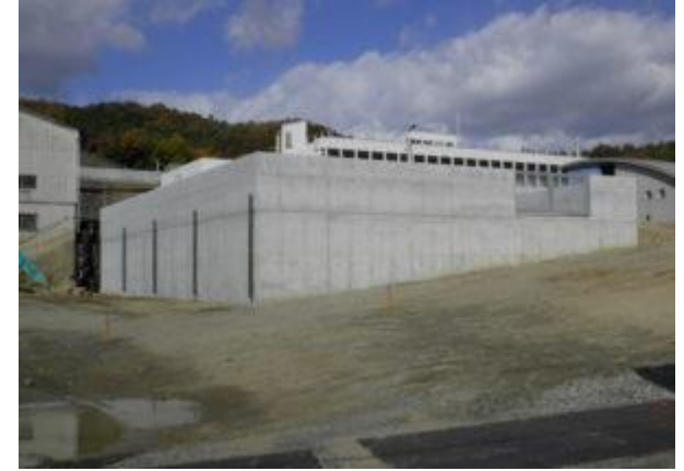
中部浄水場ポンプ井築造工事 (平成25年)
