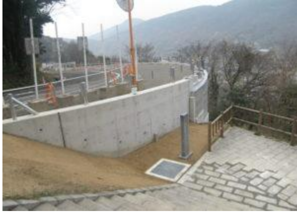
県道鴨川停車場五色台線道路 改築工事(平成28年)
